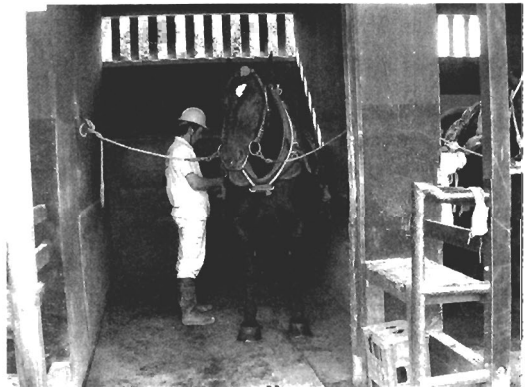
写真1 装鞍所(岩見沢競馬場)
